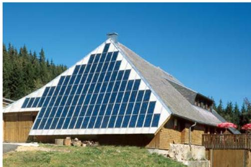
Kristalline Silicium-Photovoltaikmodule versorgen seit 1987 den Wandergasthof Rappenecker Hütte mit Strom. Die Anlage entstammt der Produktion von damals AEG, später SCHOTT Solar.
