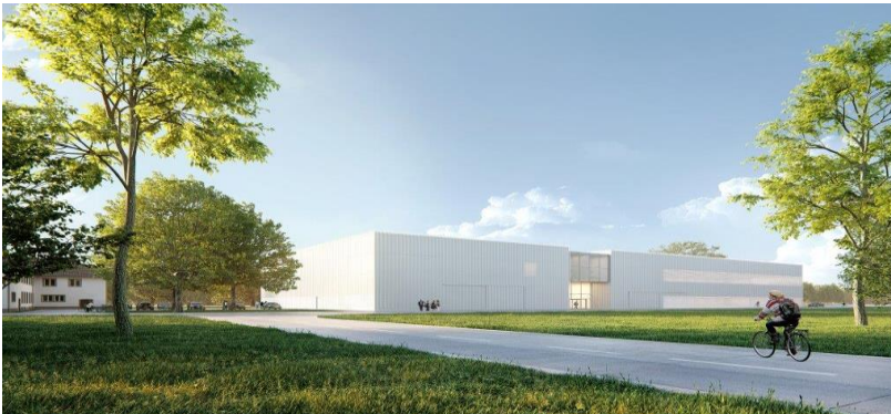
Unreife Produktionsprozesse in neuer Geschwindigkeit serienreif machen – das ist das Programm der im Bau befindlichen Karlsruher Forschungsfabrik. (Abb.: KIT)
