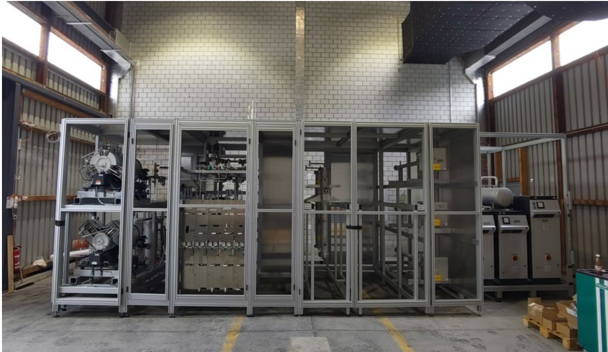
Abbildung 12: Demonstrationsanlage während der Installation
