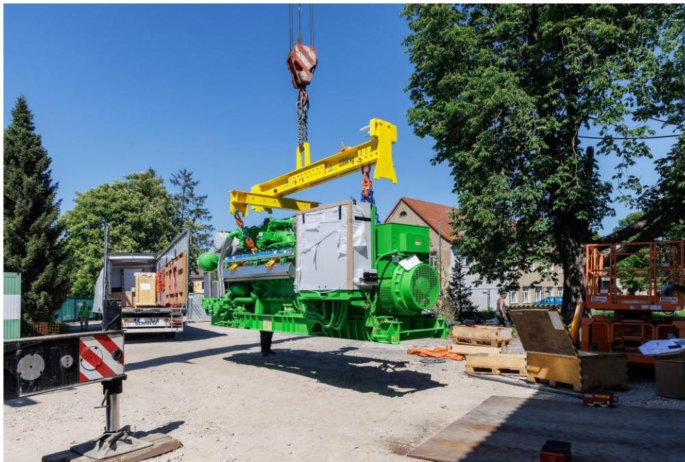
Der Gasmotor, der die KWK-Einheit der iKWK-Anlage Gera-Langenberg bildet, wird mit einem Kran vom LKW heruntergehoben und für die Einbringung in das Heizhaus vorbereitet. Bild: TWS Thüringer Wärme Service GmbH
