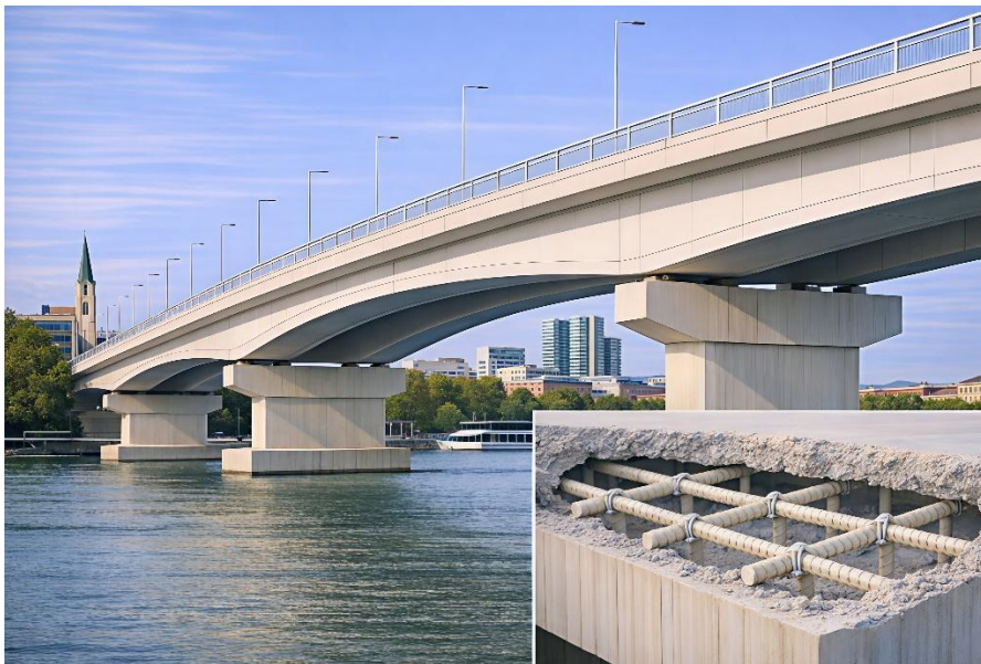
Abb. 3 Alternative zur Stahlarmierung: Pultrudierte Armierungen halten Streusalz dauerhaft stand. © Fraunhofer IWU | KI-generiert
