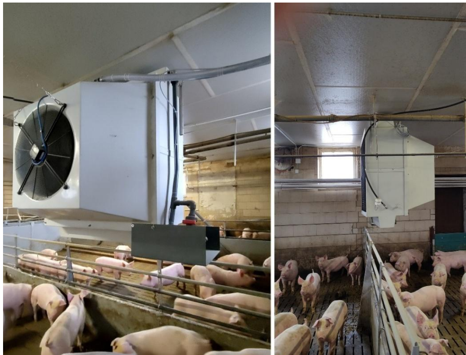
Abb. 3 »ION+« Sensorbasierte Wasserwand für besseres Stallklima in der Mastschweinehaltung«, Vortrag von Anna-Luise Böhm, Frankenförder Forschungsgesellschaft mbH, Diana Workstation/28. April 2026 © Kurt-Schwabe-Institut für Mess- und Sensortechnik Meinsberg e.V. (Jens Zosel)
