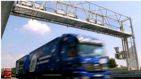
Brücken zur Verkehrsüberwachung erfassen Kennzeichen.
