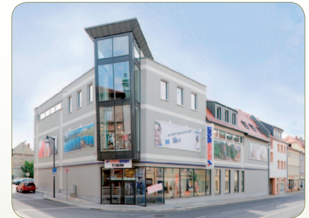
Monitoring-Objekt: Sport-Haus Timm „1. Sächsisches Geschäftshaus in Passivhausbauweise“
