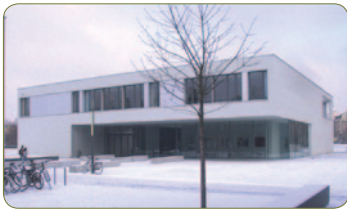
Haus IV, Hörsaal-Gebäude
