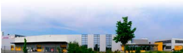
Firmengebäude der Evonik Litarion GmbH und der Li-Tec Battery GmbH in Kamenz
