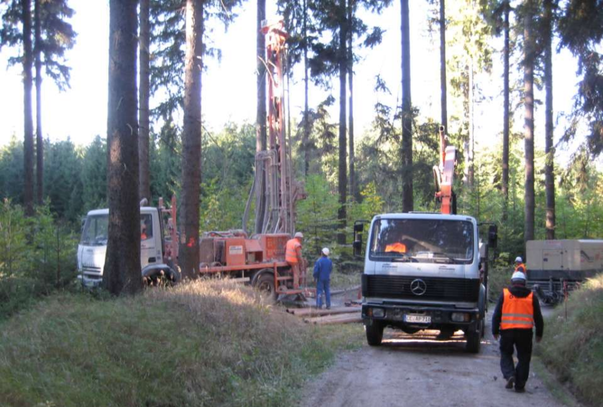
Bohrmannschaft von Celler Brunnenbau an einem von 23 Bohrpunkten Bohrungen 30 m tief, 30 kg Sprengladung, Hammer-Luft-Spülung
