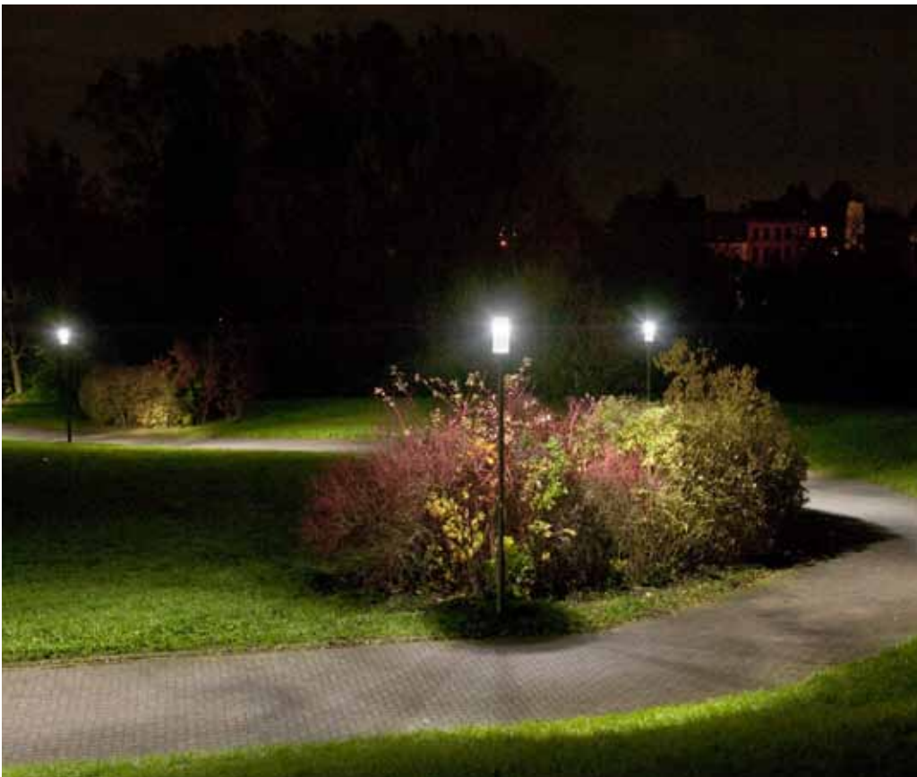
Abbildung 18: LED-Parkbeleuchtung in Görlitz © VDI Technologiezentrum GmbH
