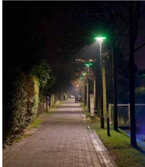
Abbildung 16: Anwohnerstraße mit LED-Beleuchtung in Rietberg © VDI Technologiezentrum GmbH
