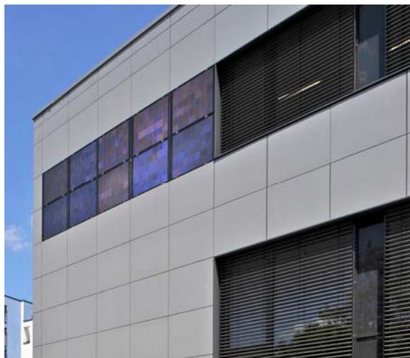
Laborneubau Fraunhofer ISE: An der Süd-West-Fassade kommen neuartige kristalline PV-Module für die Verkleidung der Außenwand zum Einsatz (HIP-MWT Solarzellen/TPedge Modultechnologie). ©Fraunhofer ISE
