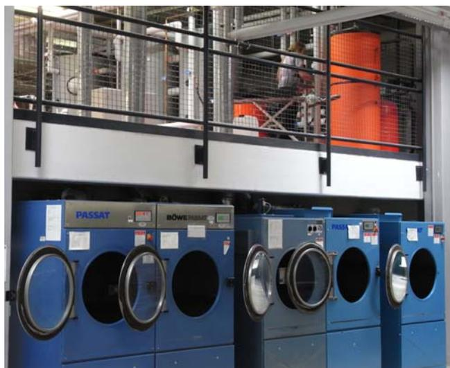
Das Fraunhofer ISE entwickelt ein Branchenkonzept für die Nutzung von Solarwärme in Wäschereien. Solarthermische Anlagen werden in die Betriebe integriert, um einen Teil des Wärmebedarfs einzelner Prozesse zu decken. Oben im Foto zu sehen sind die Speicher einer Solaranlage, die Wärme für Kessel-Zusatzwasser, Kessel-Speisewasser und Waschmaschinen bereitstellt. ©Fraunhofer ISE
