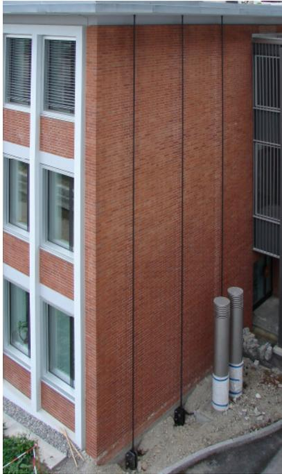
Montage von CFK-Kabeln zur Stabilisierung bei Erdbeben an den Fassaden des Verwaltungsgebäudes der Empa im Jahr 2008.
