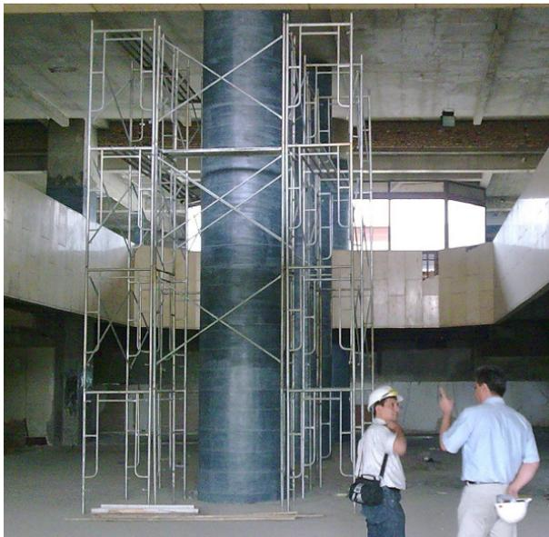
Blick in die Halle des Teheraner Hotels Azadi: Um das 28 Stockwerke hohe Hotel erdbebensicher zu machen, wurden die zehn Meter hohen Stützen aus Stahlbeton mit CFK-Gewebe umwickelt.
