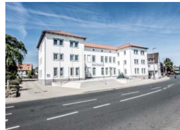
Eingangsseite des Rathauses Vechede vor und nach Umbau und energetischer Sanierung (Generalplanung ASSMANN BERATEN + PLANEN GmbH)
