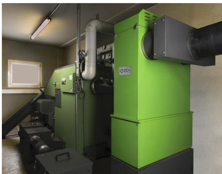
Der CCA-Abscheider (hellgrün) entfernt effektiv Feinstaub aus dem Rauchgas von holzbeheizten Kesselanlagen. (Bild: KIT/M. Breig)
