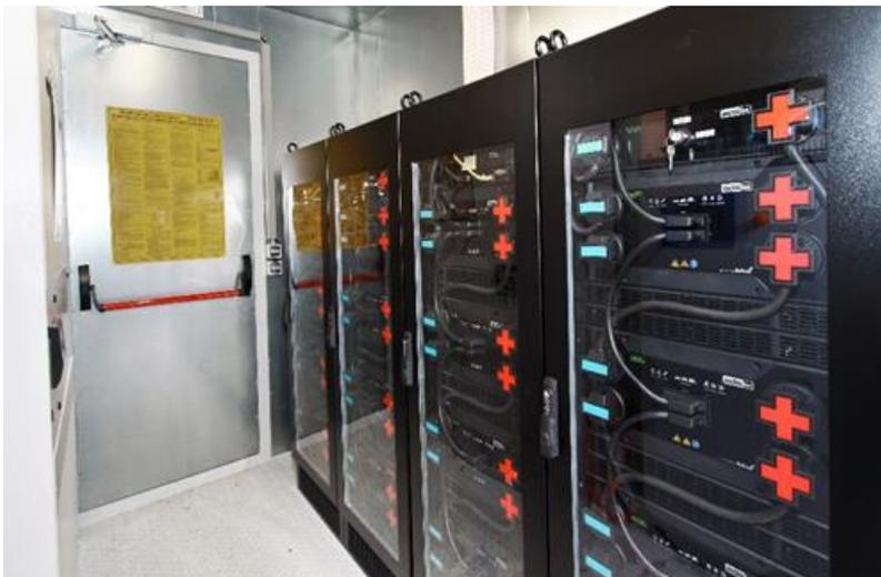
In den Batterien wird der Solarstrom gespeichert und nach Bedarf in das Betriebsnetz des HIU eingespeist. (Foto: Frederik Elschenbroich, ads-tec)
