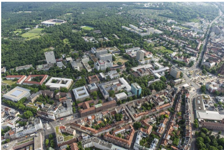
Bei urbanen Wärmeinseln in Städten wie Karlsruhe spielen Faktoren wie Besiedlung, Flächenversiegelung, Vegetation, Wärmeabstrahlung von Gebäuden, Industrie und Verkehr zusammen. (Bild: KIT).
