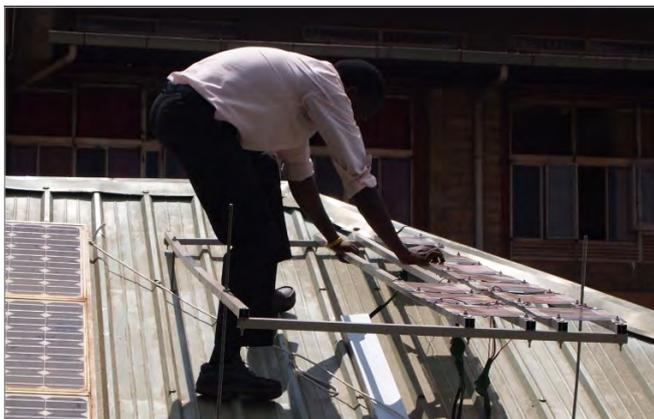
**Montage von Solarzellen aus dem TREASURES-Projekt für einen Langzeittest unter Extrembedingungen in Uganda.**
