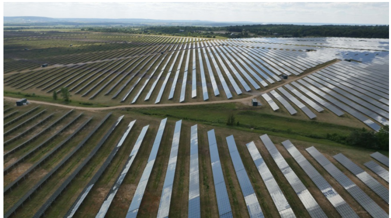
Solkraftwerk in Toul, Frankreich (115 MW p ) ©EDF Energies Nouvelles
