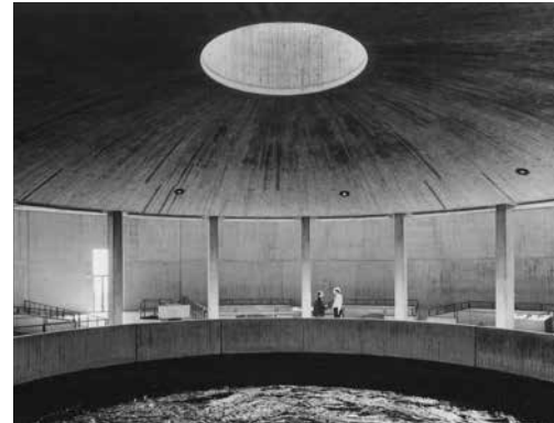
8 Seewasserwerk, Mikrosieb- und Ozonanlage Sipplinger Berg, 1970
