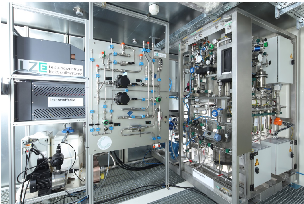
Das Innere des neuartigen Containers ermöglicht die effiziente Verstromung und Produktion von Wasserstoff. Foto: Kurt Fuchs / Fraunhofer IISB
