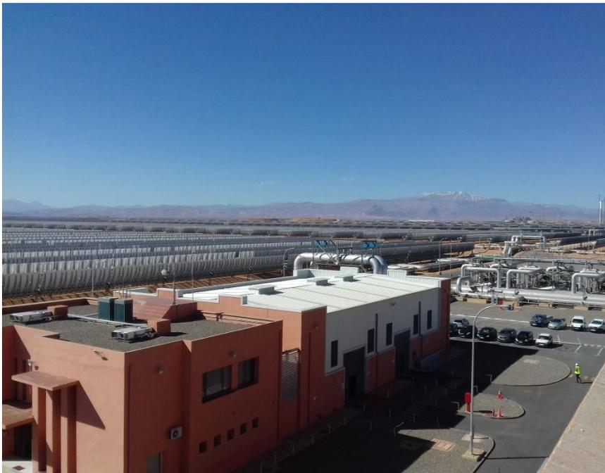
Das Noor CSP Kraftwerk in Ouarzazate, Marokko. Das Parabolrinnenkraftwerk ist mit einem thermischen Speicher gekoppelt, um mit dem Kraftwerk auch die abendliche Spitzenlastzeit in Marokko abzudecken. Das Fraunhofer ISE untersucht unter anderem die Netzintegration solcher Großkraftwerke. ©Fraunhofer ISE
