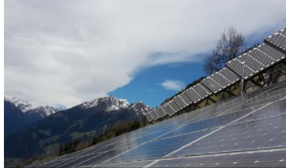
Bildtext 2: In den Anden setzt die Höhenstrahlung den Solaranlagen zu, in Saudi Arabien verschlechtert Sand die Leistung, auf Teneriffa gibt es Probleme mit der Luftfeuchtigkeit und in den österreichischen Alpen bringt die Schneedecke im Winter Einbußen. Unterschiedliche Bedingungen beeinflussen den Solarstromertrag. Klimaangepasste PV-Lösungen legen die Basis für ertragsoptimierte Systeme mit verlängerter Systemlebenszeit. © ENcome Energy Performance GmbH
