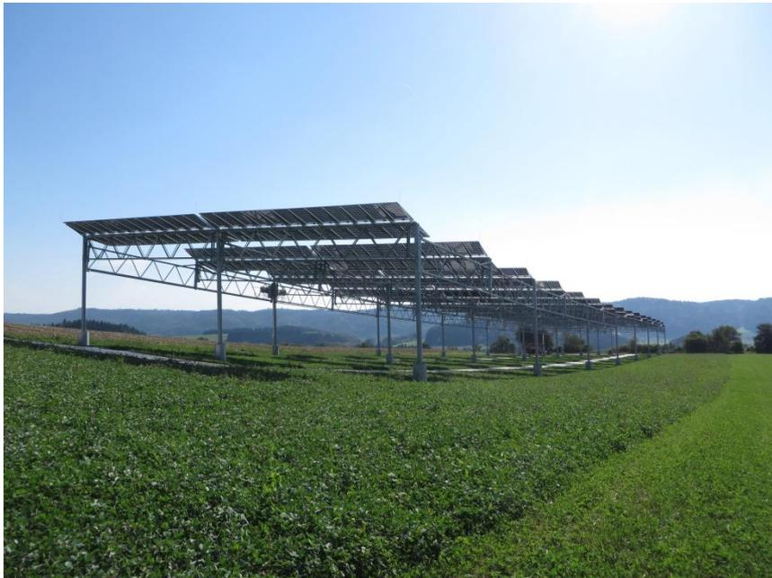
Die Agrophotovoltaik verbindet Landwirtschaft und Photovoltaik auf der gleichen Fläche, wie hier bei der Pilotanlage in Heggelbach am Bodensee. © Fraunhofer ISE
