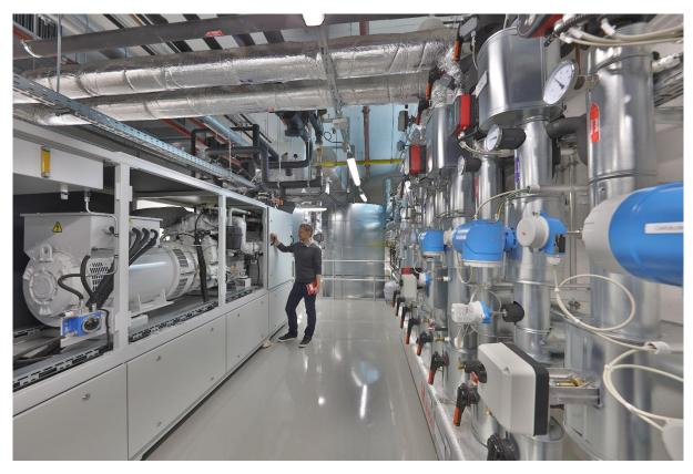
Blockheizkraftwerk und Warmwasserspeicher im Untergeschoss des Fraunhofer IISB: Die Kraftwärme-Kopplungsanlage wurde im Rahmen des Erweiterungsbaus B in die Infrastruktur des Instituts integriert. Dort wird sie sowohl zur Wärme- und Stromversorgung als auch als Forschungsanlage genutzt. Bild: Kurt Fuchs / Fraunhofer IISB
