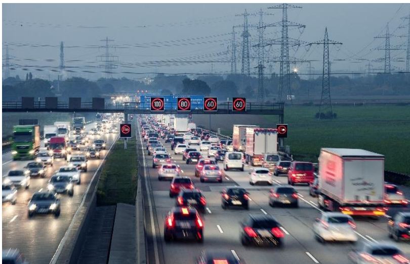
Streckenbeeinflussungsanlagen (SBA) sorgen für eine erhöhte Verkehrssicherheit auf Autobahnen, hier im morgendlichen Berufsverkehr am Nordwestkreuz Frankfurt. (Foto: Hessen Mobil Straßen- und Verkehrsmanagement)
