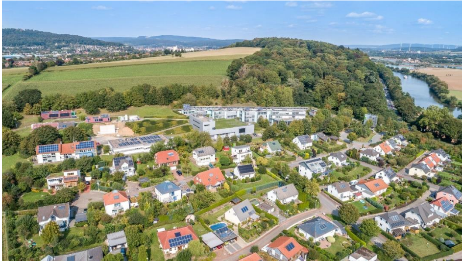
Solarsiedlung mit 70 Niedrigenergie-Häusern am Südhang des Ohrbergs bei Hameln, eines der vom ISFH untersuchten Quartiere. Bildquelle: ISFH
