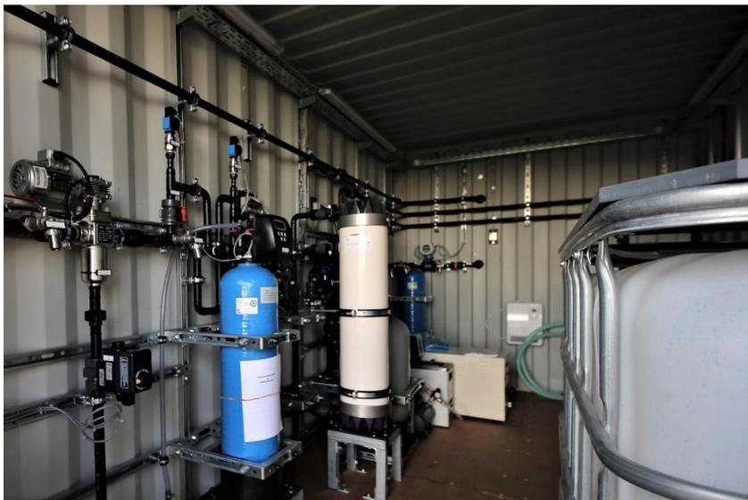
Mobile PHYSICS FOR FOOD Wasseraufbereitungsanlage in der Cosun Beet Company Anklam. Demonstrator inklusive Grob- und Feinfilter, Ozon-, UV-, Aktivkohle-, Ultraschall-, Plasma- und PEF-Modulen. (Foto: INP)
