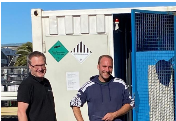
Abb. 4 Sören Scheffler und Thomas Grabsch (UMSTRO GmbH) bei der Inbetriebnahme des Microgrids auf dem Gelände von Alu-Cab © Fraunhofer IWU
