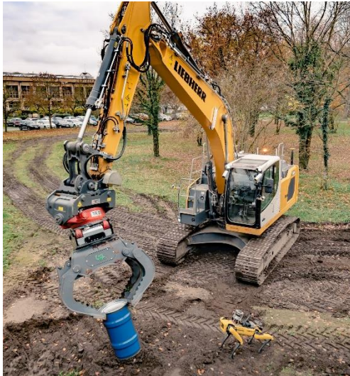
Ein Team autonom agierender Roboter (Robo-Hund und Bagger) in Aktion: Ein Eindruck von aktuellen Tests am Fraunhofer IOSB.
