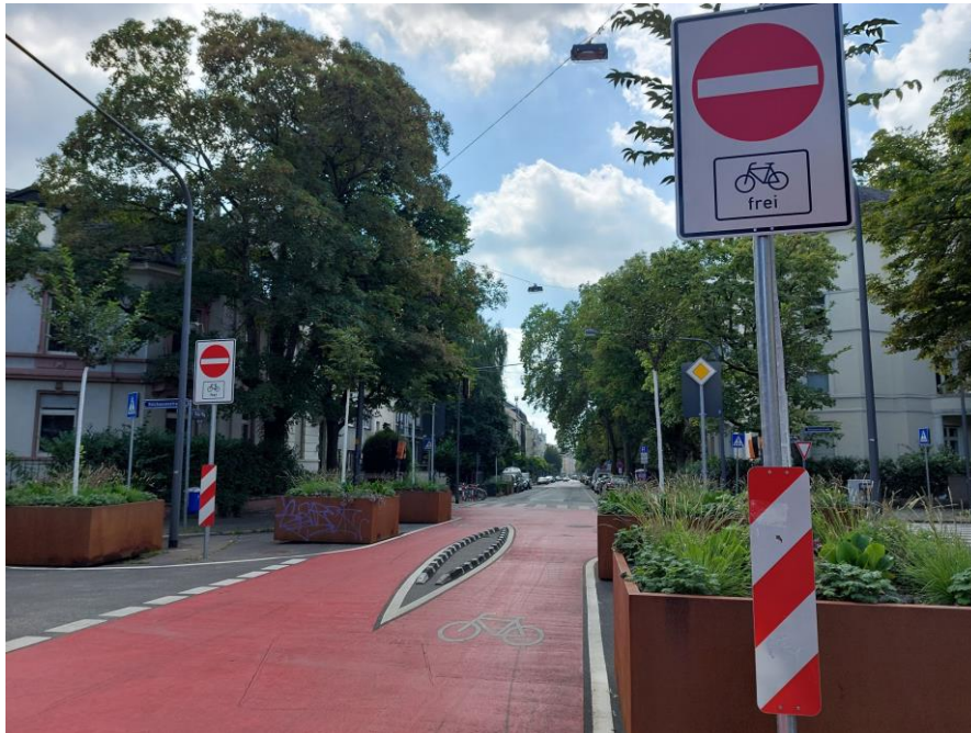
Abbildung 44: Provisorische Diagonalfilter am Knotenpunkt Holzhausenstraße, Blickrichtung Süden (Quelle: Eigene Aufnahme)
