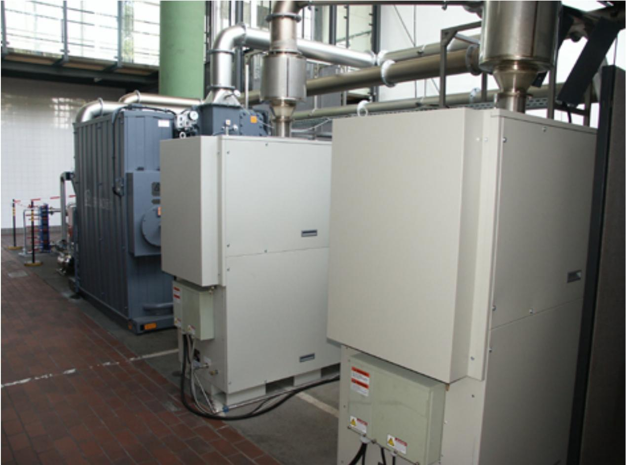
Die Kälteabsorptionsmaschine (hinten) mit Turbinenaggregaten (vorne)
