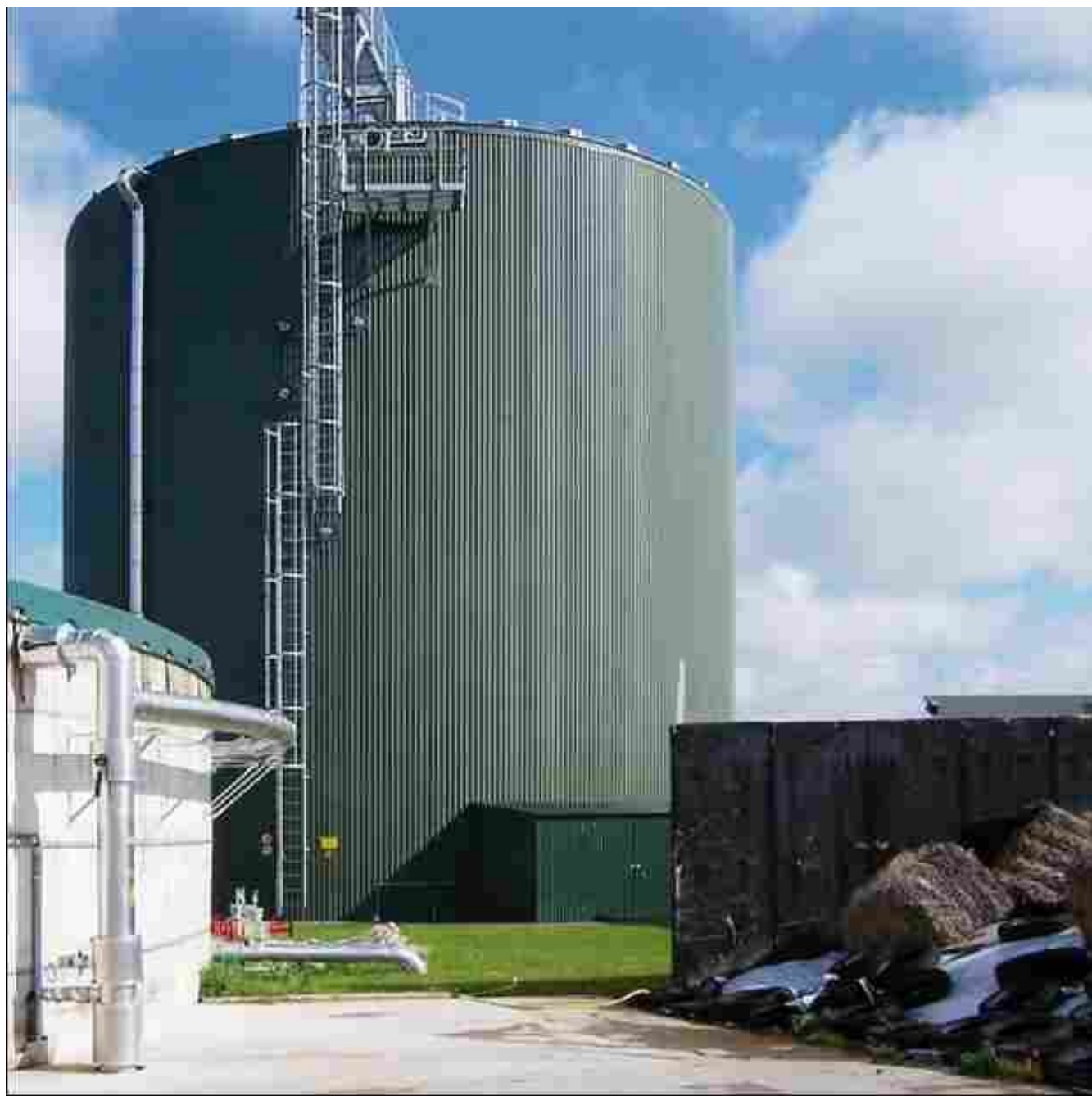
Der Fermenter der Biogasanlage in Bobitz bei Wismar. HAWK
