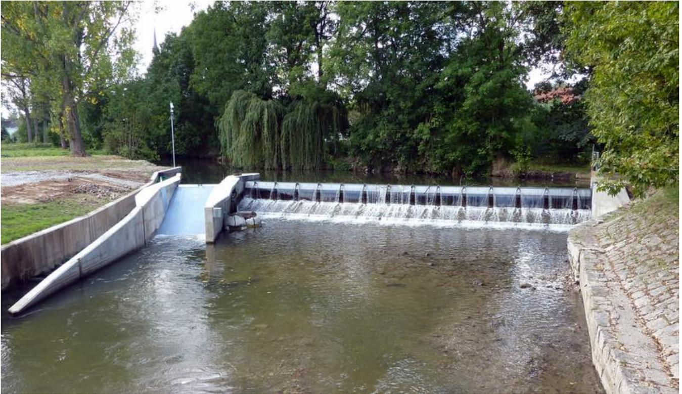
Wasserkraftanlage Bad Sulza: Die neue Kraftanlage unter Wasser am Ilmwehr im Kurpark von Bad Sulza. Trotz der geringen Fallhöhe des Wassers kann hier Energie gewonnen werden. Links ist der Fischpass, der Wanderweg für Fische, zu sehen.
