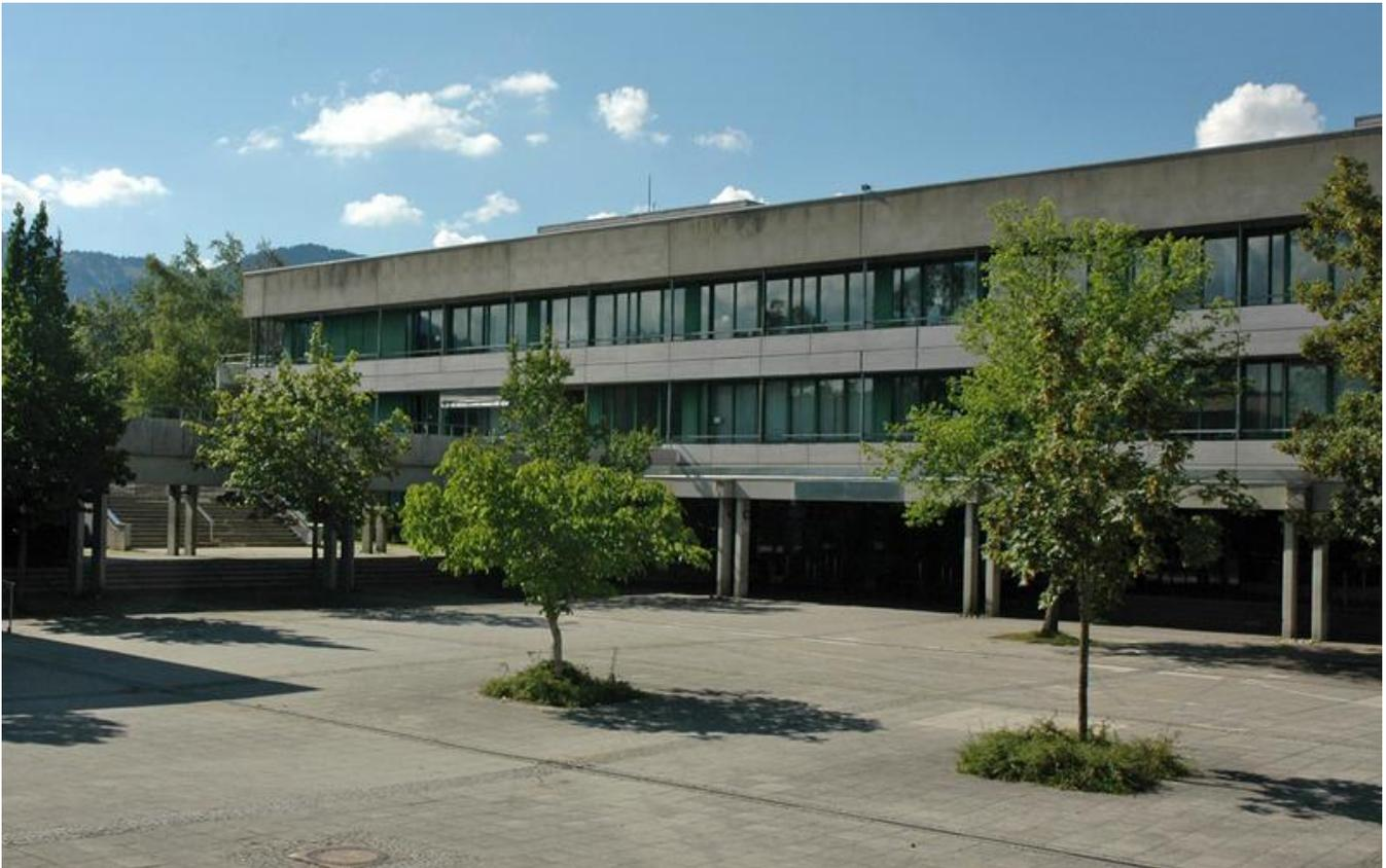
Typische Bauweise der 60er und 70er Jahre: Nutzung von Fertigteilen aus Stahlbeton. Nach der Grundsanierung umgibt das Gebäude eine hoch Wärme dämmende Holzfassade.
