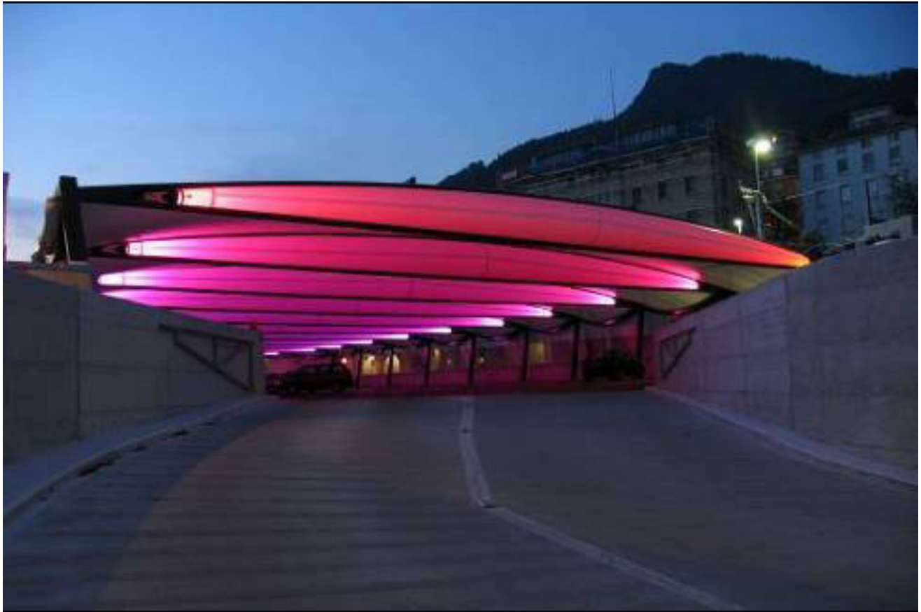
Das Dach dieses Parkhauses in Montreux, Schweiz wurde mit der aufblasbaren Leichtbautragstruktur Tensairity® erbaut. Bald könnte es mit einer selbstreparierenden Beschichtung ausgerüstet sein.
