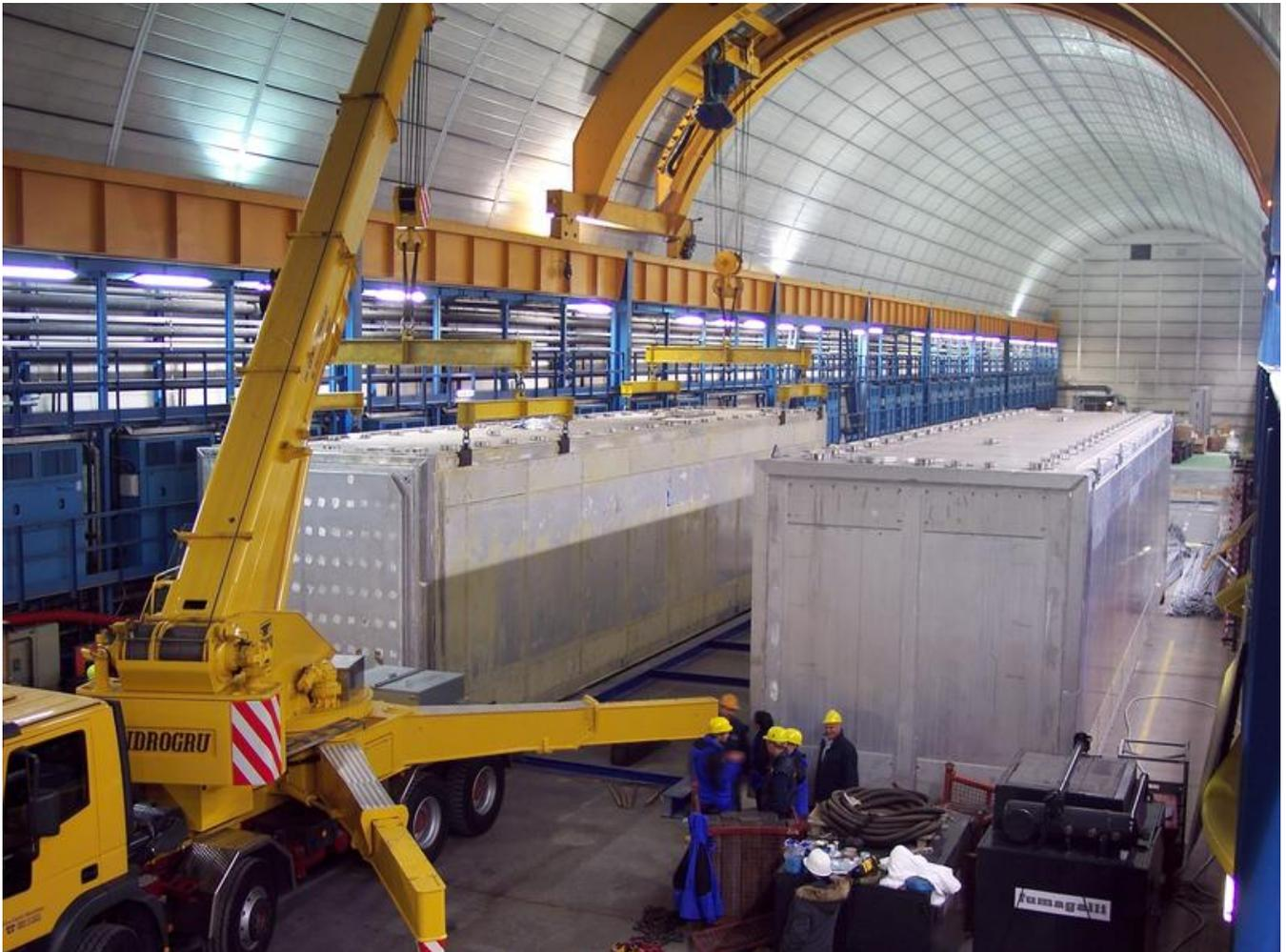
Kernstück des Wissenschaftsprogramms ICARUS ist ein 80 Meter langes und 15 Meter hohes Messgerät aus der VDM-Nickellegierung Pernifer 36. Damit die Untersuchungen frei von störenden Umwelteinflüssen erfolgen können, liegt der 600 Tonnen schwere Detektor tief unter der Erde.
