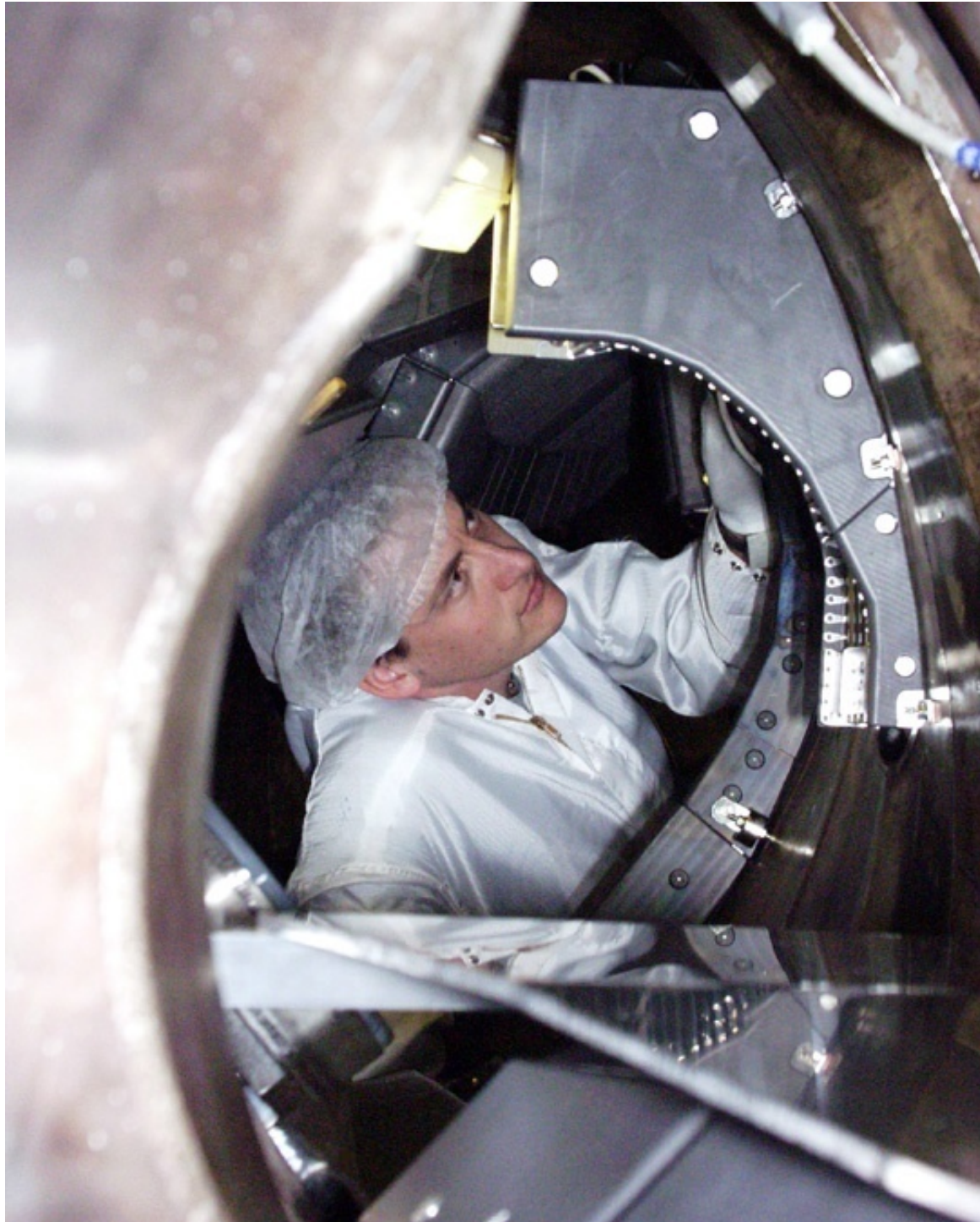
Einbau der Divertor-Bauteile in das Plasmagefäß von WENDELSTEIN 7-A
