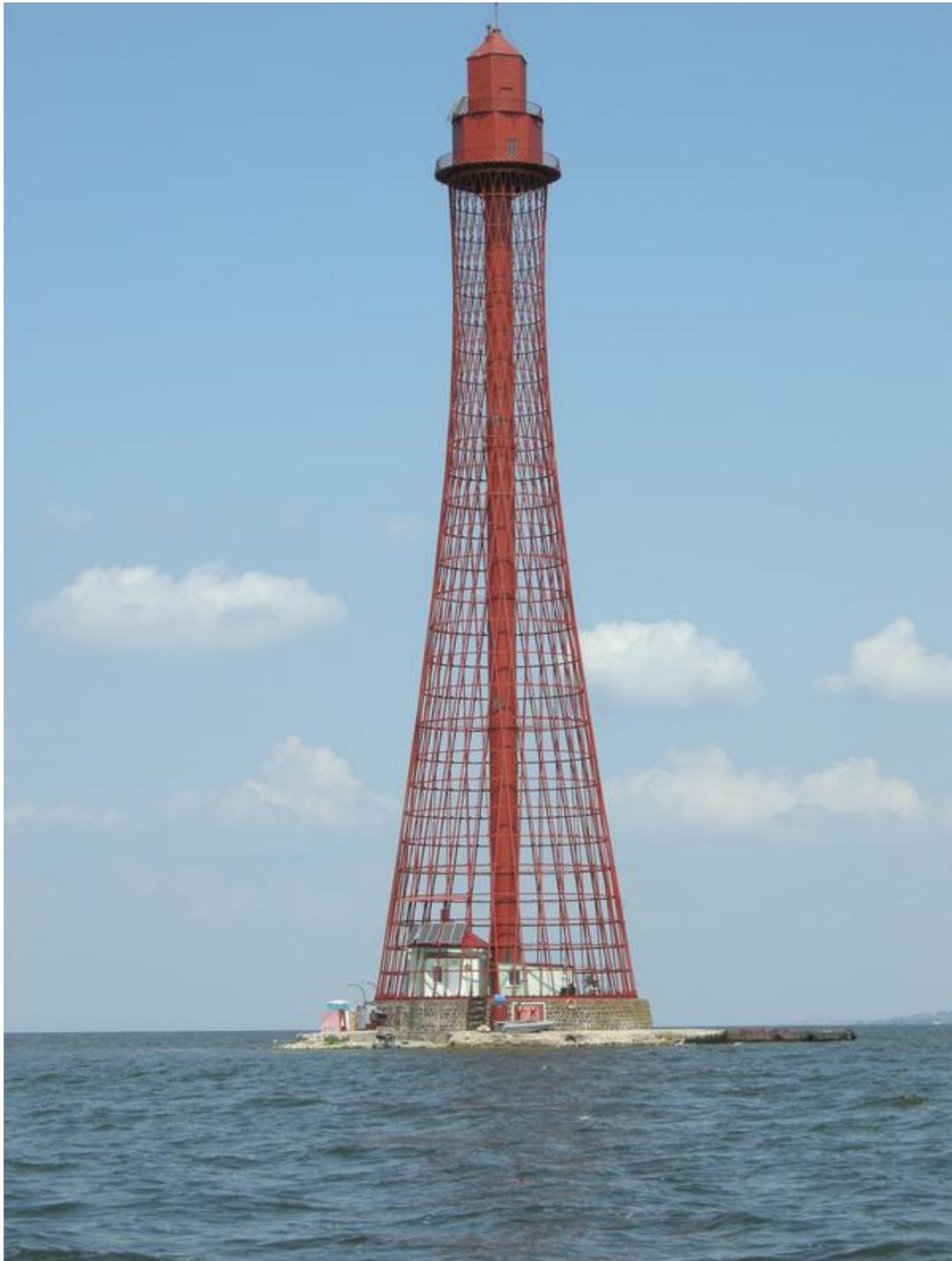
Leuchtturm in der Dnjepir-Mündung, erbaut von Vladimir G. Schuchov 1911. Schuchov erfand die Gitterkonstruktion aus verdrehten, sich überkreuzenden Stabreihen.
