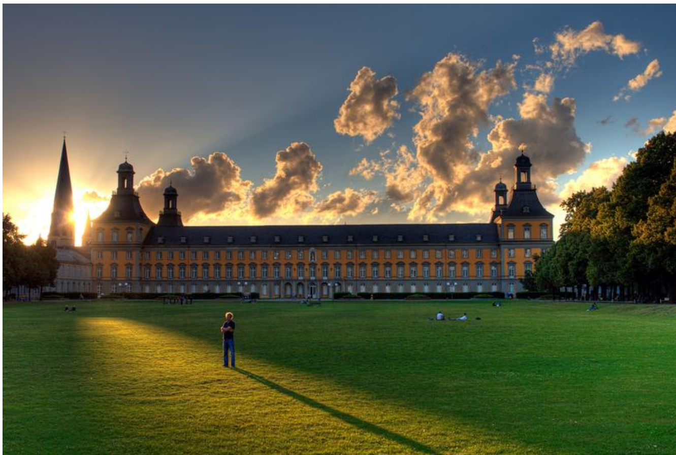
Nur ein Lichtblick von vielen: Das Hauptgebäude der Universität Bonn im Sonnenuntergang. Foto: Dr. Thomas Mauersberg/Uni Bonn
