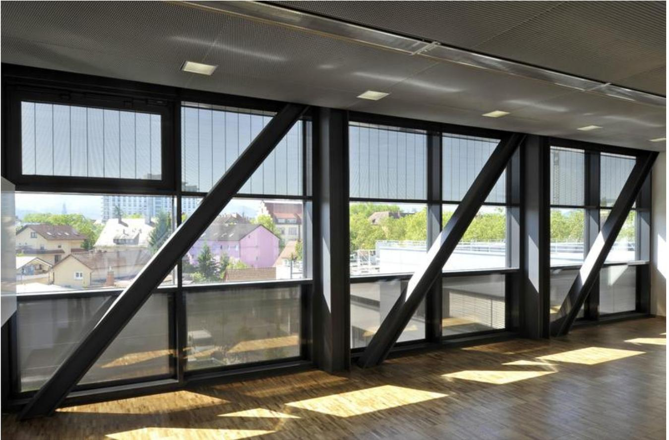
Laborneubau Fraunhofer ISE: Seminarraum mit bauwerksintegrierter Photovoltaik (BIPV) – teiltransparente PV-Module mit winkelselektiver Transmission (PV-Shade®).
