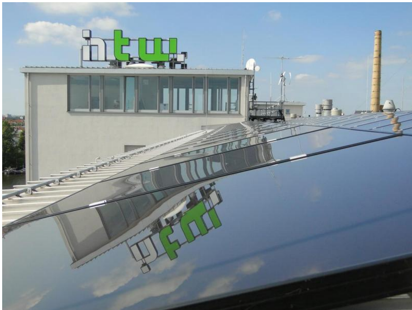
Photovoltaik auf dem Dach der HTW Berlin © HTW Berlin/einleuchtend e.V,
