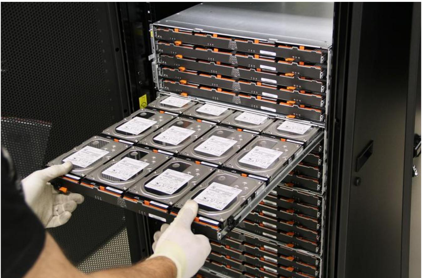
Einschub einer Festplatteneinheit für das High Performance Storage System am DKRZ Böttinger, DKRZ
