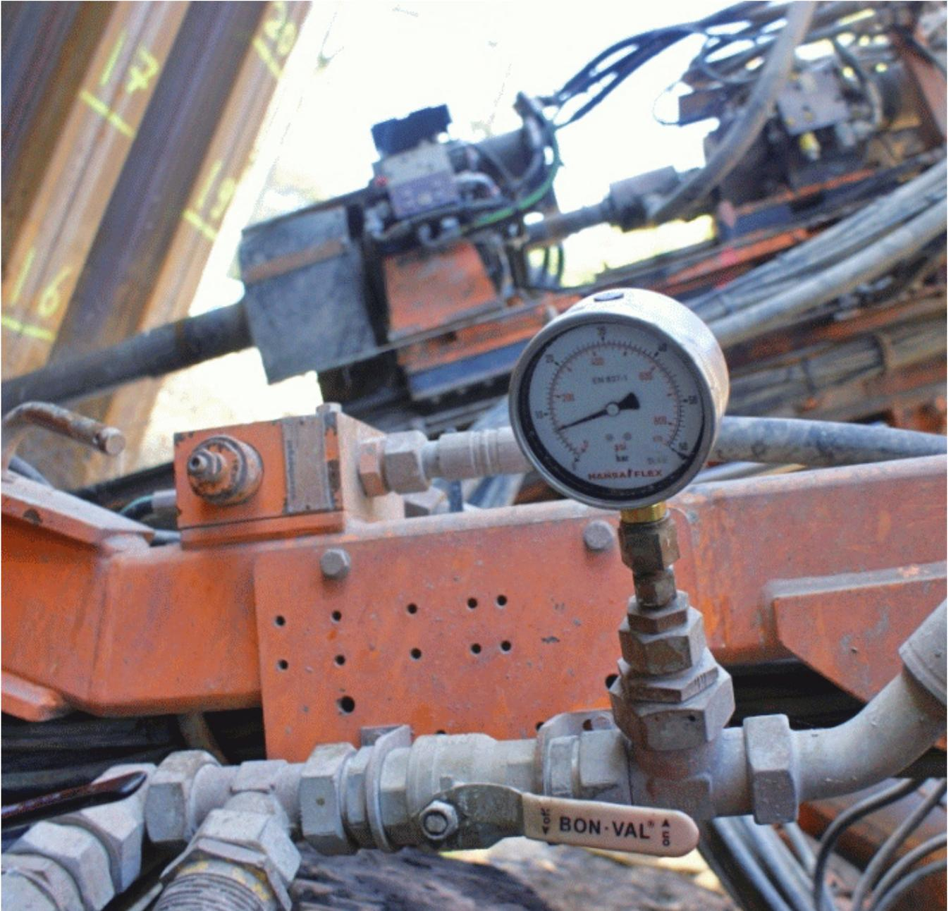
Messung des Verpressdrucks bei der Ankerherstellung
