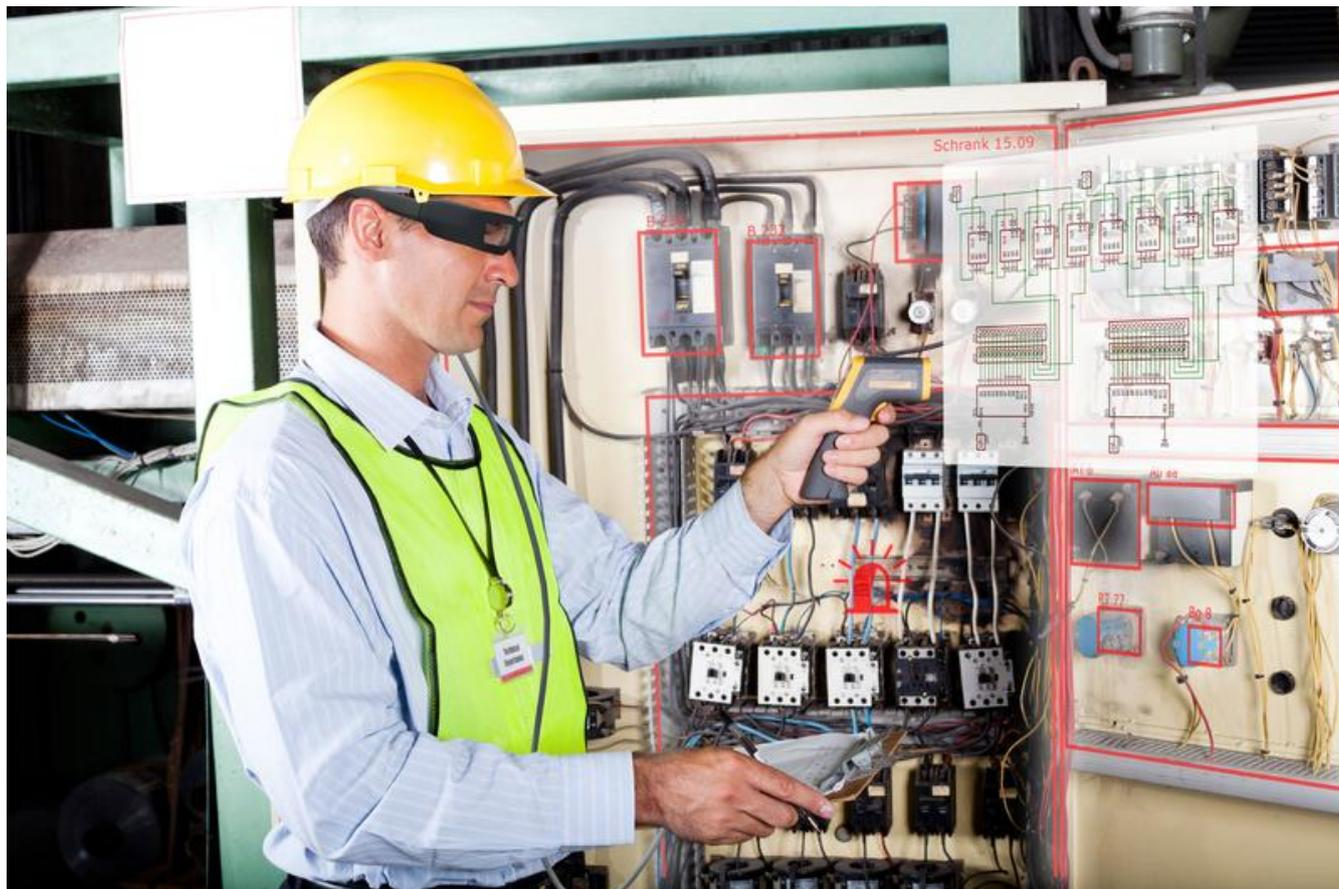
Arbeiten mithilfe einer Datenbrille: Das „AR Maintenance System“ erkennt die Raumgeometrie des Schaltkastens, blendet Lage- und Schaltpläne ein, und es dokumentiert die Arbeit.
