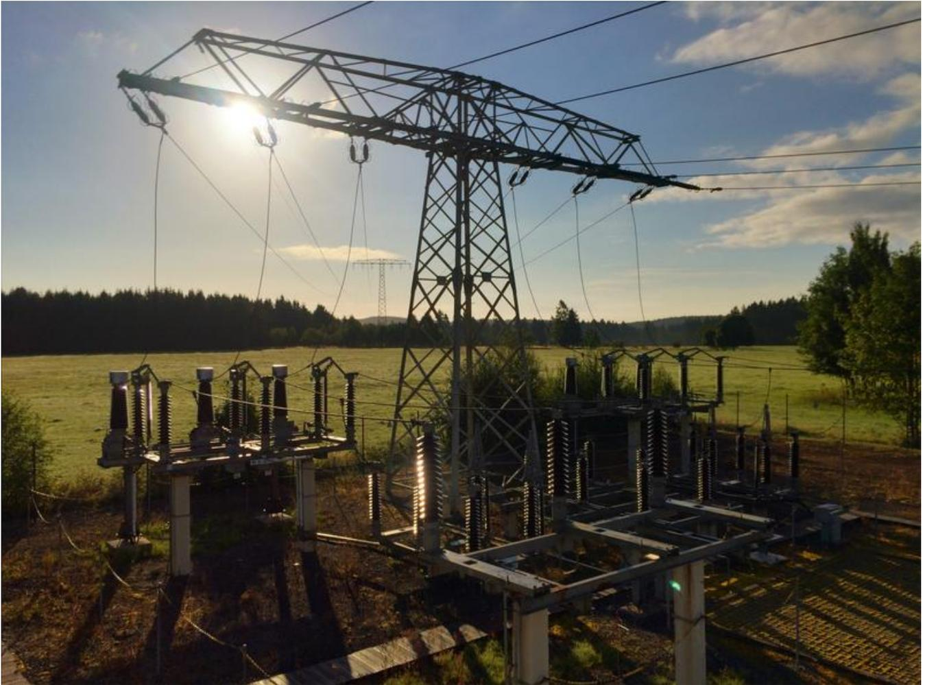
Ein Freileitungsmast des Umspannwerks in Benneckenstein. Dieses Umspannwerk wurde im Rahmen der Installationstätigkeiten mit neuartigen Überwachungssystemen ausgestattet.
