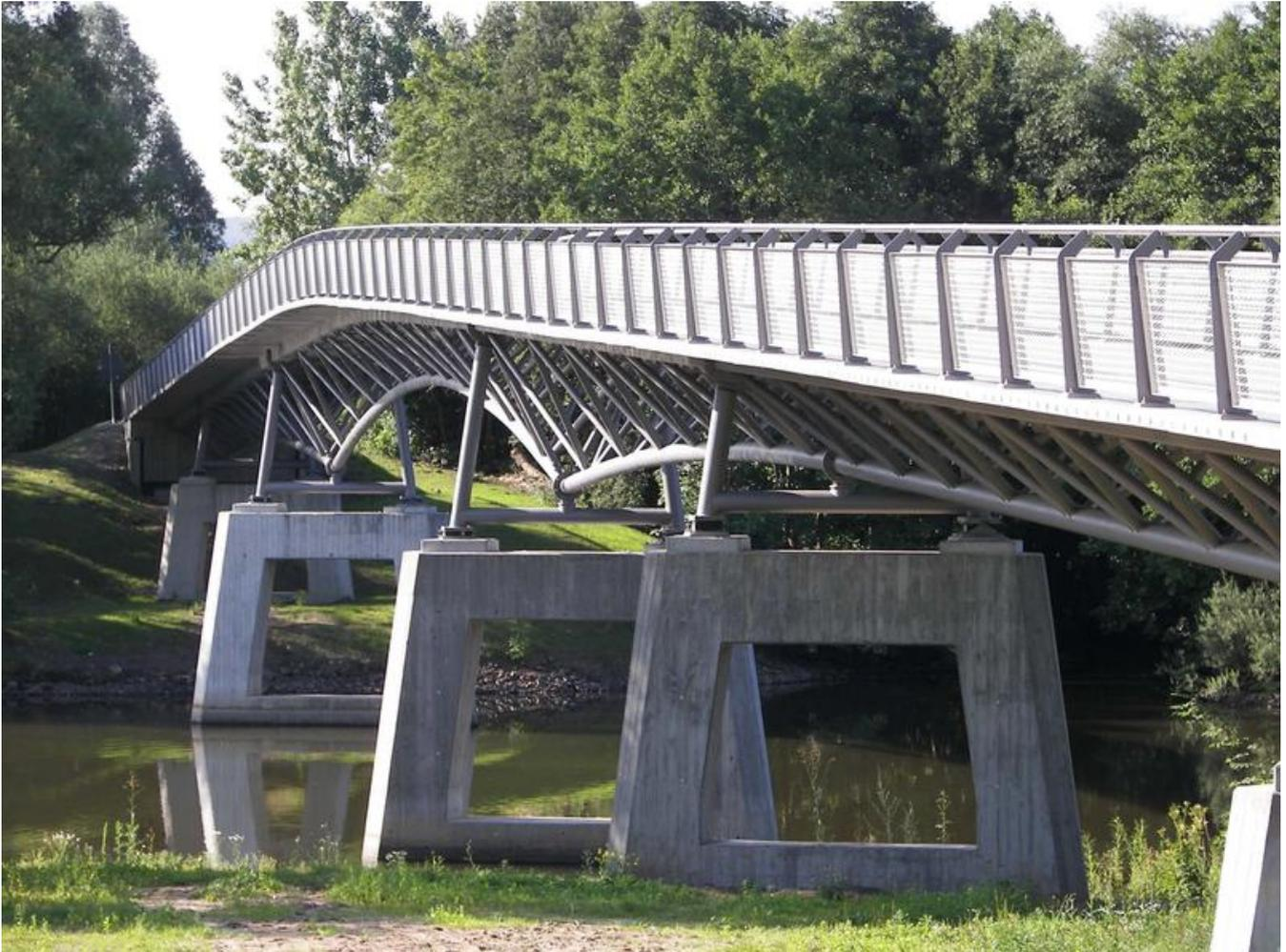
Die Gärtnerplatzbrücke in Kassel wurde mit ultrahochfestem Beton gebaut, der an der Uni Kassel weiterentwickelt wird.
