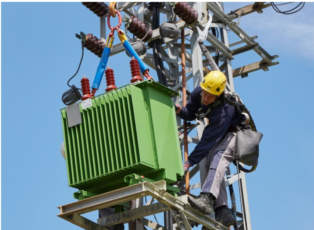
Die grüne Alternative: Für das Innovationsprojekt liefert Siemens die ersten grünen Verteiltrafos. Im Bild: Montage eines Pflanzenöl-Trafos auf einer Gittermaststation.
