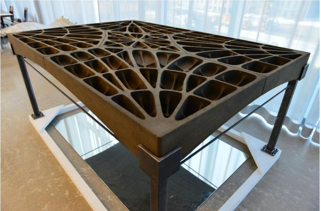
Die Platten, aus denen dieser Boden zusammengefügt wurde, bestehen aus 3D-gedrucktem Sand.
